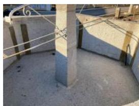
Im Zuge der Kanalgrabungsarbeiten wurde weiters das komplette Zuleitungs- und Abwassersystem unseres Marktbrunnens erneuert. Dieses war schon sehr in die Jahre gekommen und an einigen Stellen sehr schadhaft. Auch wurde bereits der Marktbrunnen fachgerecht saniert und abgedichtet.
